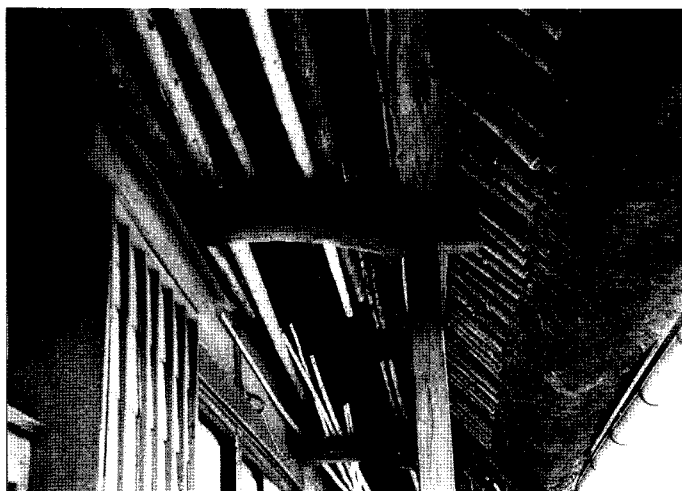
中原区内に残る茅葺（鉄板覆い）・軒のつくり
